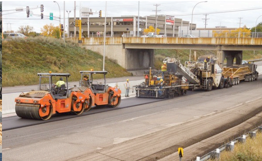
Exemple de construction routière
