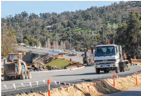
Exemple de travaux d'amélioration routière
