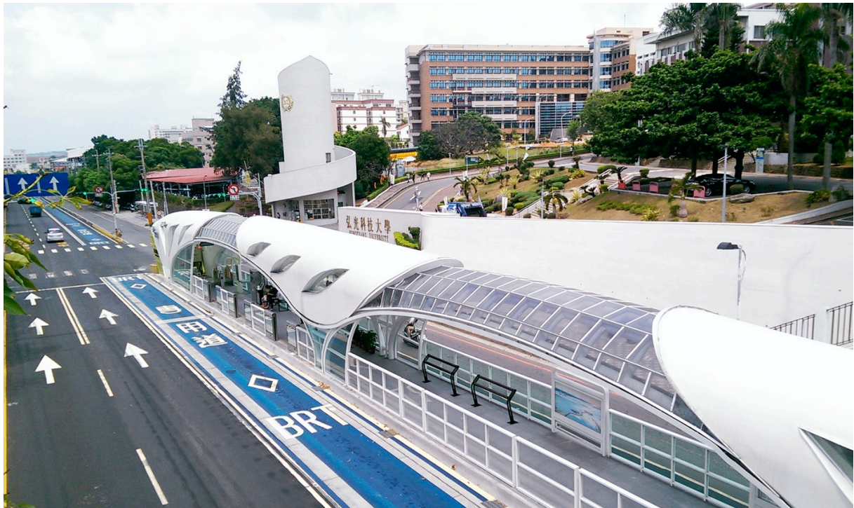
Exemple d'une gare à TAIWAN
